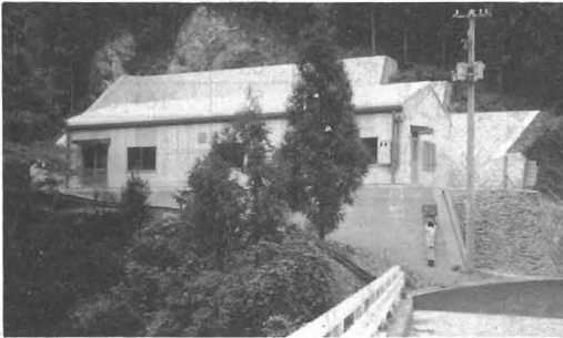
昨年七月に完成した中・横簡易水道浄化施設
