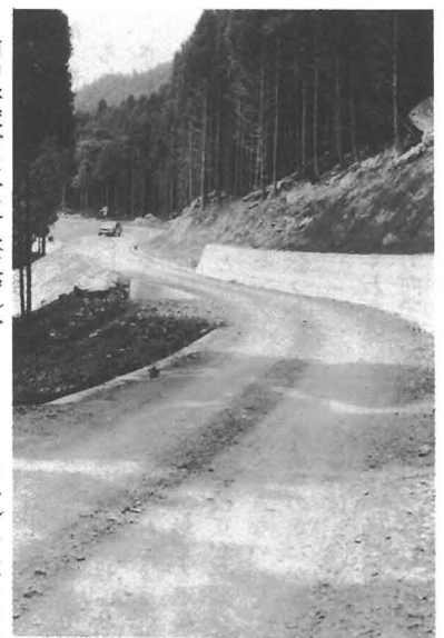
全線開通した婆羅尾林道、完全舗装が完了している
