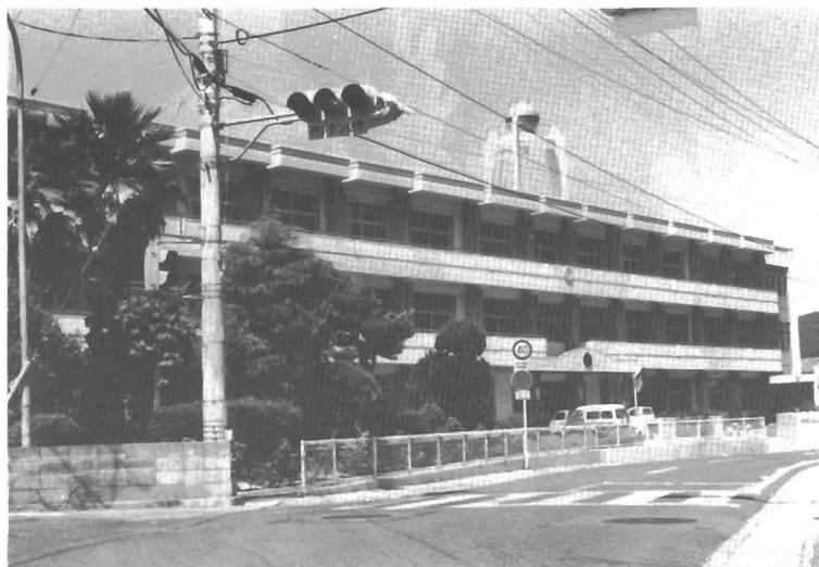
完成した生比奈小学校
