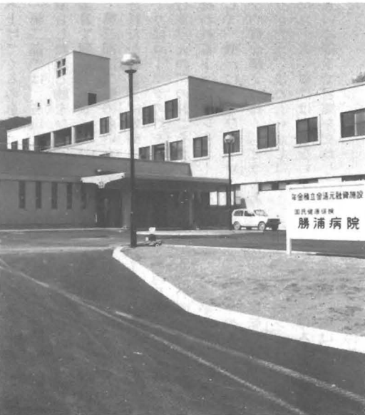
5月に開院する勝浦病院の正面玄関
