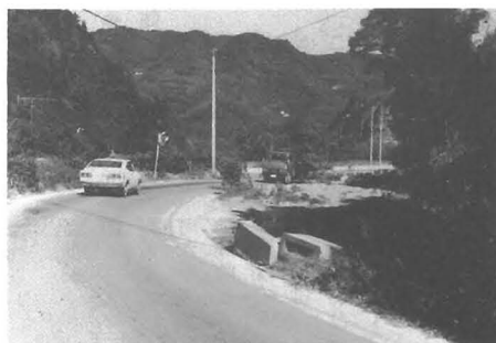
改良して全線二車線に
