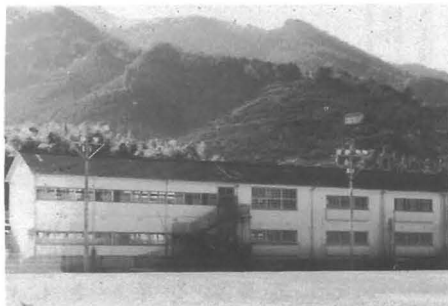
改築予定の生比奈小学校
