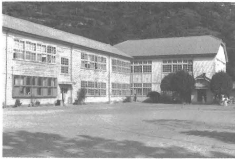
↑坂小改築工事も昨年12月20日に着工
