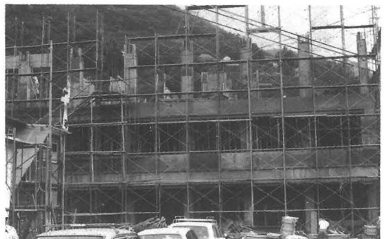
建設が進む坂本小学校
