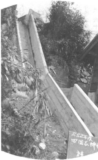
四国谷排水路
