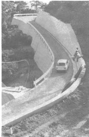
農山漁村同和对策事業により工事が進む農道横尾線
