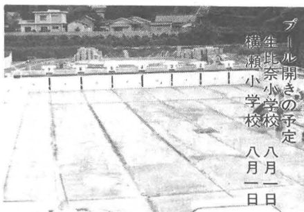
横瀬小学校のプール建設工事
