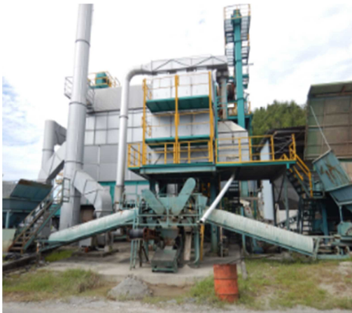
《アスファルト合材再生プラント》
