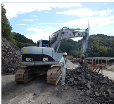
《建設廃材、アスから》
