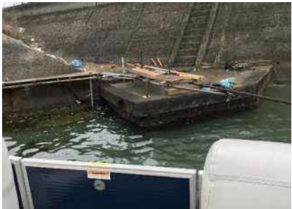
船着場設置候補箇所の現況調査
