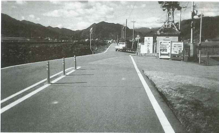
見通しが悪く危険な堤防上道路
