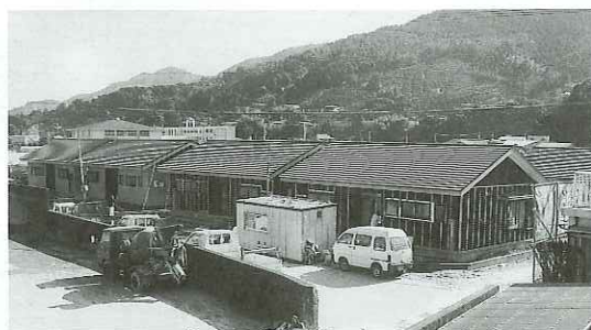
建築中の中角公営住宅
