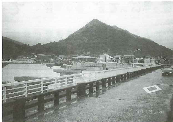
平成9年の横瀬橋
