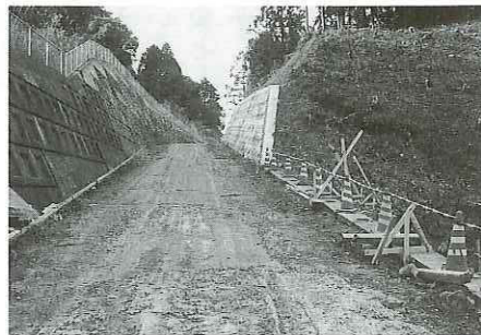
工事中の南岸農免道路
