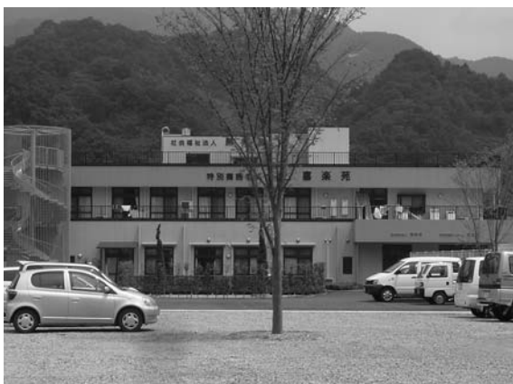
▶ 増床された特養施設
