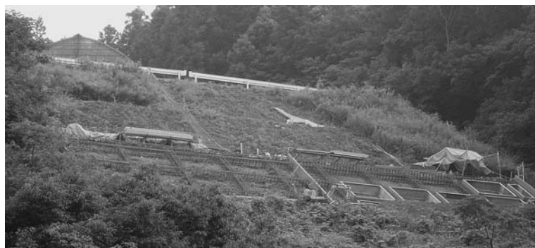
▶ 花団地の災害復旧工事
