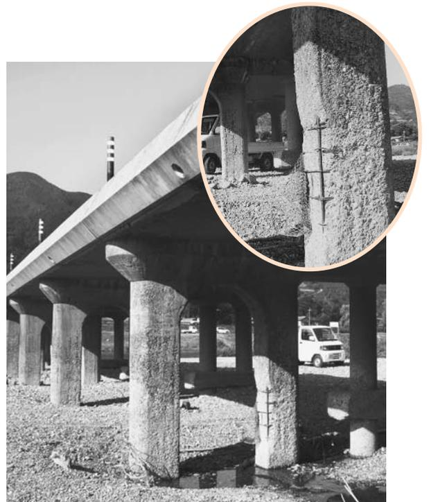
鉄筋がむき出しになっている橋脚
