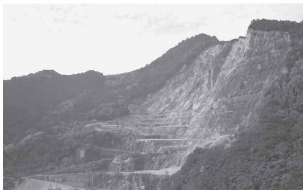
止めれるんで？ 残土搬入
