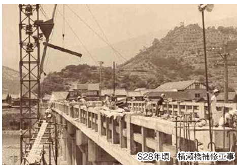
S28年頃 横瀬橋補修工事
