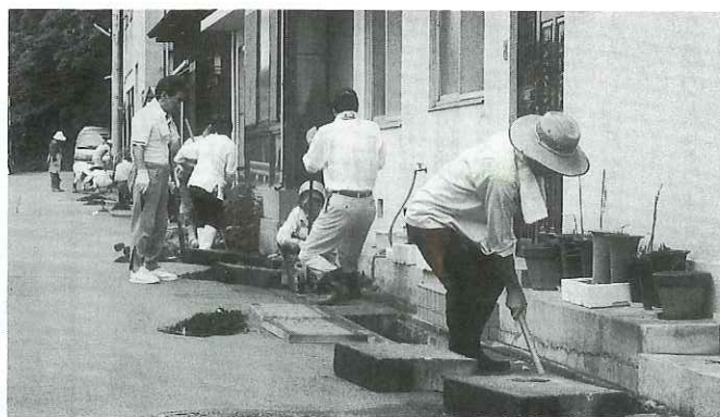
側溝のブロックを取り除いての清掃は大変です。(横瀬地区)
