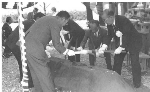
◀工事の無事を祈りクワ入れが行われました
