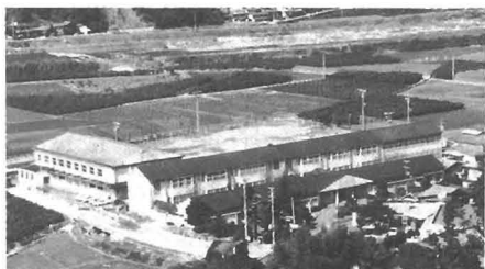
改築される生比奈小学校
