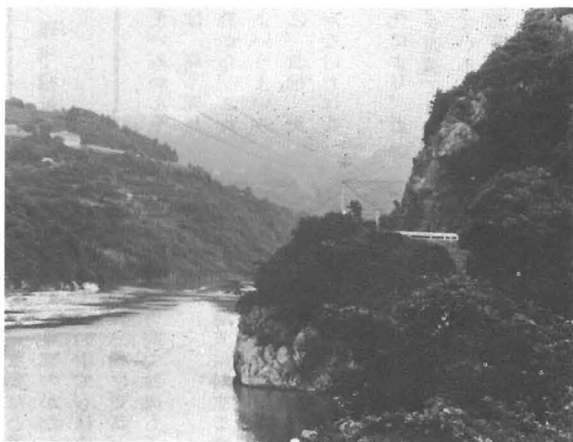
大返りの掘削工事も11月ごろには着工予定。
