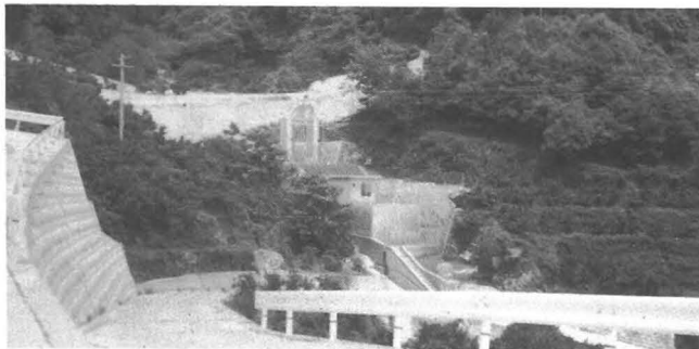
→完成した水源地の全景
