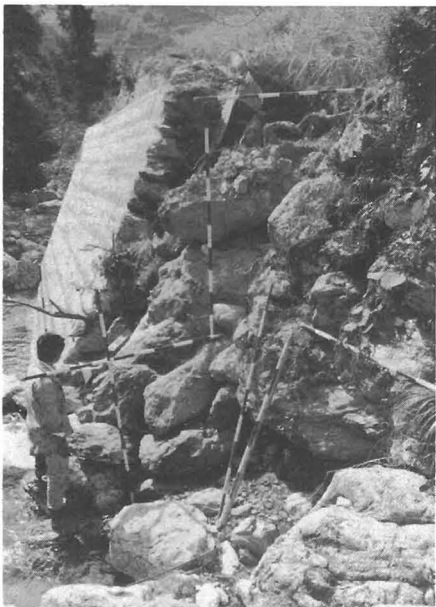
台風17号による災害復旧工事がされる町道と川内中道線(上)と大伏尾谷川(下)
