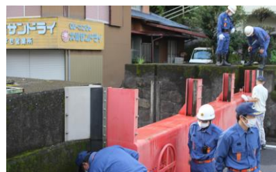
樋門（中角区）開閉訓練
