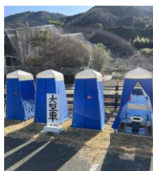
道の駅 マンホールトイレ
