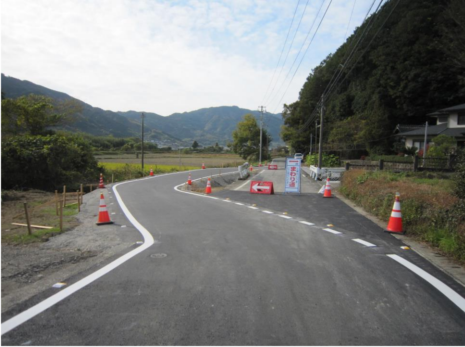
仮設道路の写真 (畑総水管橋更新工事)
