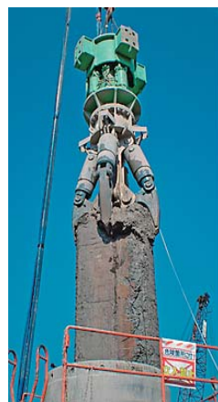
テレスコピックブーム式クローラークレーン『TK550』 杭抜き オーガーケーシング工法
