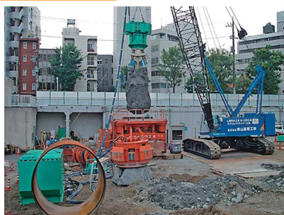
ケーシング掘削回転工法
