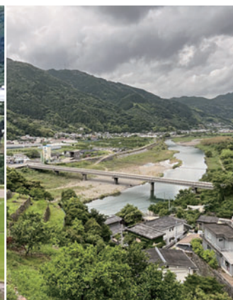
勝浦中央橋 (黒岩橋)
